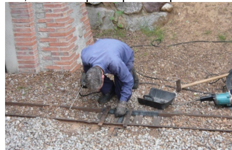
Preparat per soldar un tros de rail ja canviat. Seguidament es farà l'altre
