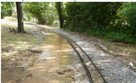
Una de les inundacions. La via fa de presa.
